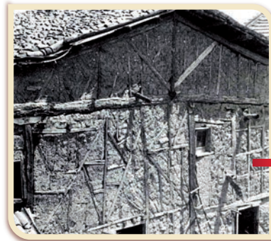
Esempio di abitazione costruita in opera a graticcio con riempimento d'argilla (case a telaio) nella regione di Bursa in Turchia (da J.P. Adam, "L'arte di costruire presso i Romani", Milano 1988, p. 61, fig. 134).
