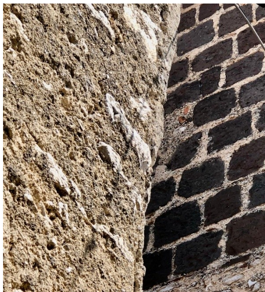
Fig. 9 Parete laterale casa Cassella in Calvisi. Conci a facciavista in tecnica mista
