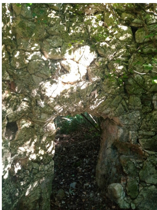
Fig. 1 Varco di accesso della calcara
