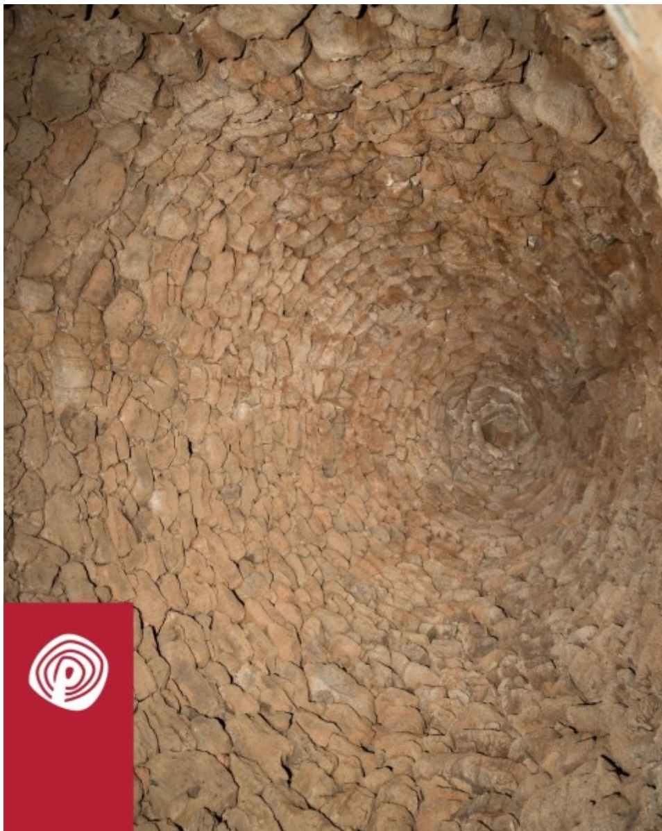
La Torre centrale del nuraghe Arrubiu
