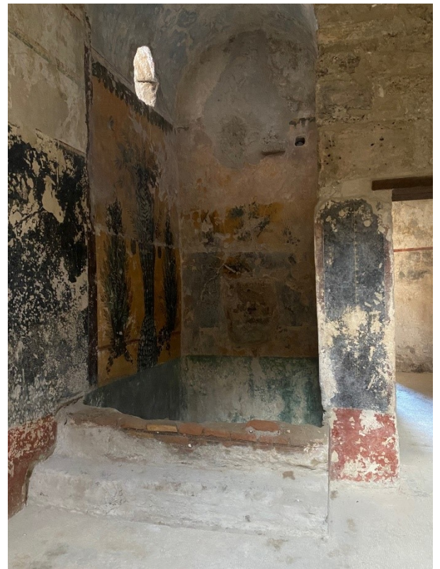
Dopo il restauro
