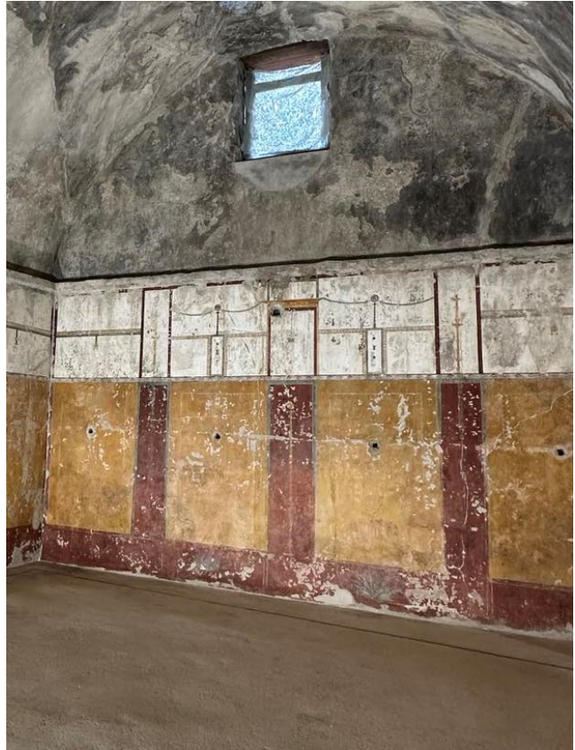
Dopo il restauro
