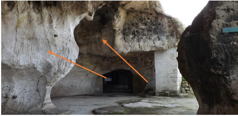
Fig. 2: ingresso del Complesso Rupestre di San Michele delle Grotte di Gravina in Puglia, con indicazione delle cavità originarie al livello superiore, ed i segni della lavorazione dell'abbassamento del livello di calpestio
