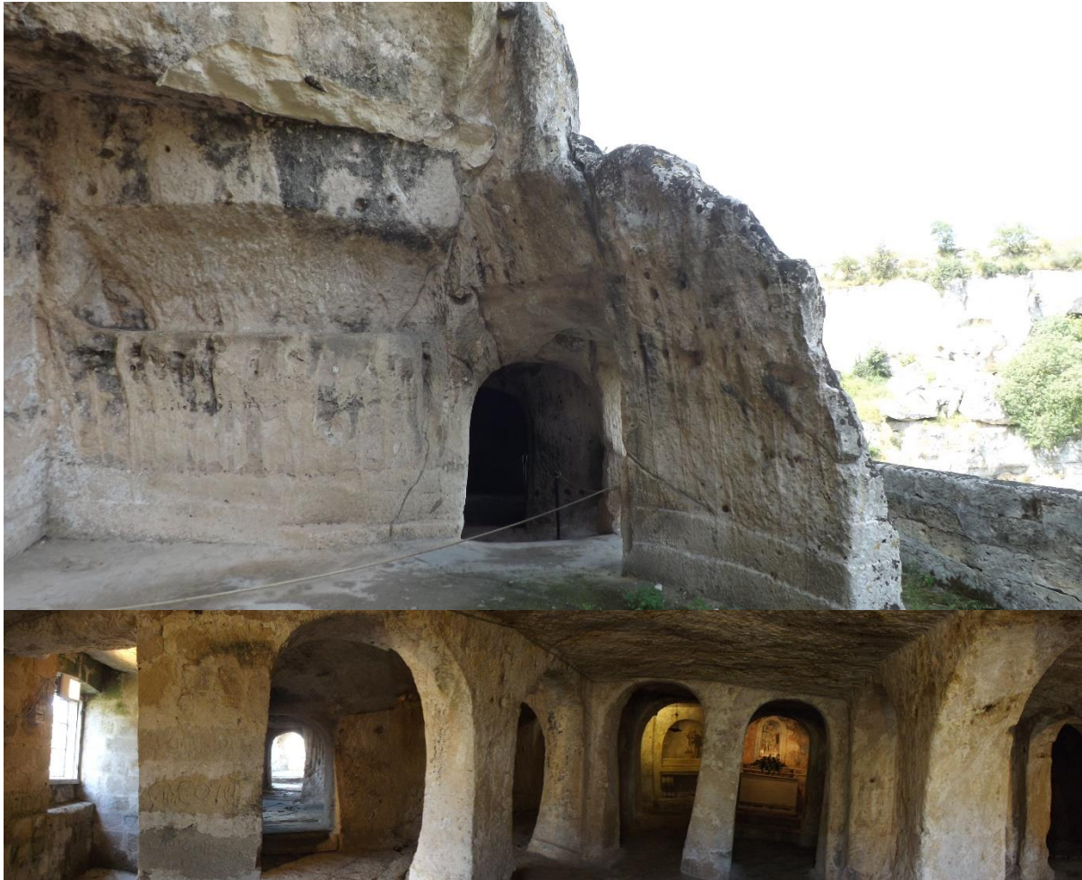
Fig. 9: foto del corridoio d'ingresso alla chiesa, visto dall'esterno, e dall'interno
