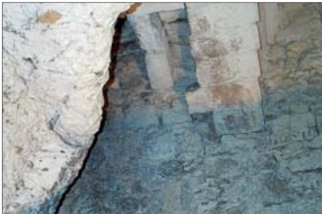
Fig. 11. - Taranto. Palazzo dei Ponti. Fondazioni della chiesetta altomedievale costruita sopra l'area sepolcrale ipogea (foto De Vitis).
