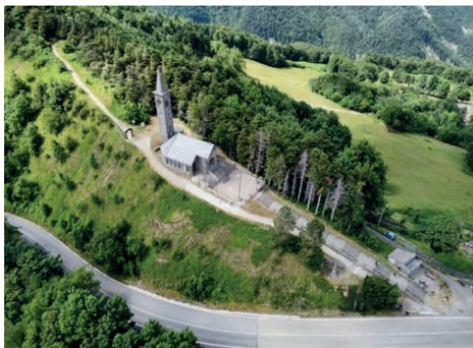
FIGURA 51- La postazione di segnalazione torciera al Valico della Cisa ( dal web )
