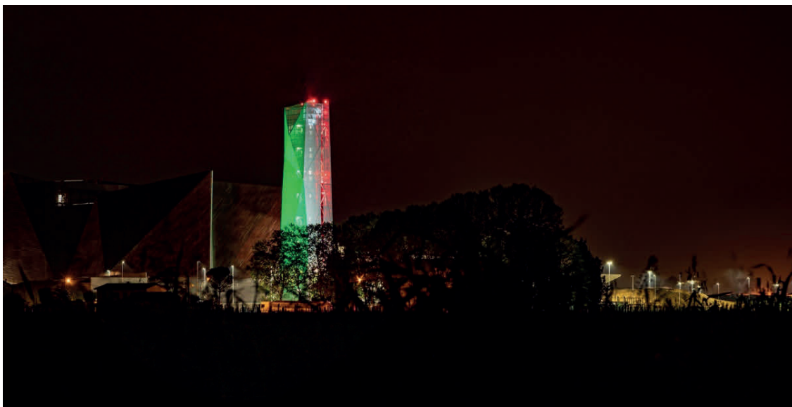
FIGURA 90 - Nel contesto: Torre del Polo delle Energie Rinnovabili di Russi che per l'occasione ha assolto egregiamente alla funzione di postazione torciera, tra Faenza e Ravenna, permettendo di superare l'inquinamento luminoso che avrebbe impedito il passaggio del senale torciera. Disponibili tutti, anche se interpellati all'ultimo minuto. Un grazie ancora più grande da parte di tutta la filiera del percorso! (Foto Polo Energie Rinnovabili e Assessore Prof.ssa Maria Grazia Bagnoli)
