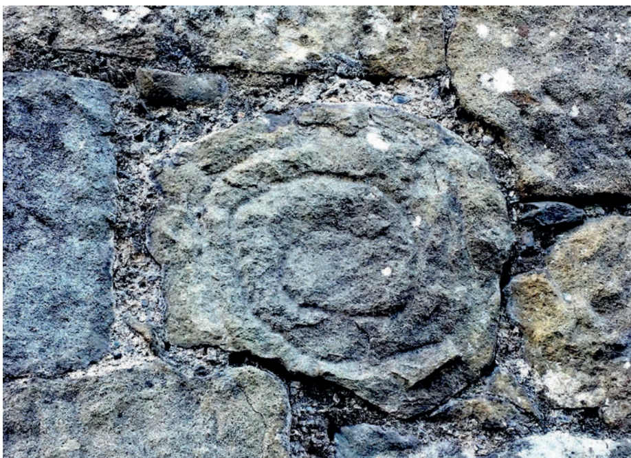
FIGURA 67 - Nel tessuto murario extraurbano, il singolare riutilizzo di una pietra in arenaria con l'incisione di un labirinto di fattura non artistica, ma importante in quanto indice di antica e diffusa religiosità popolare. (Foto A.M.)
