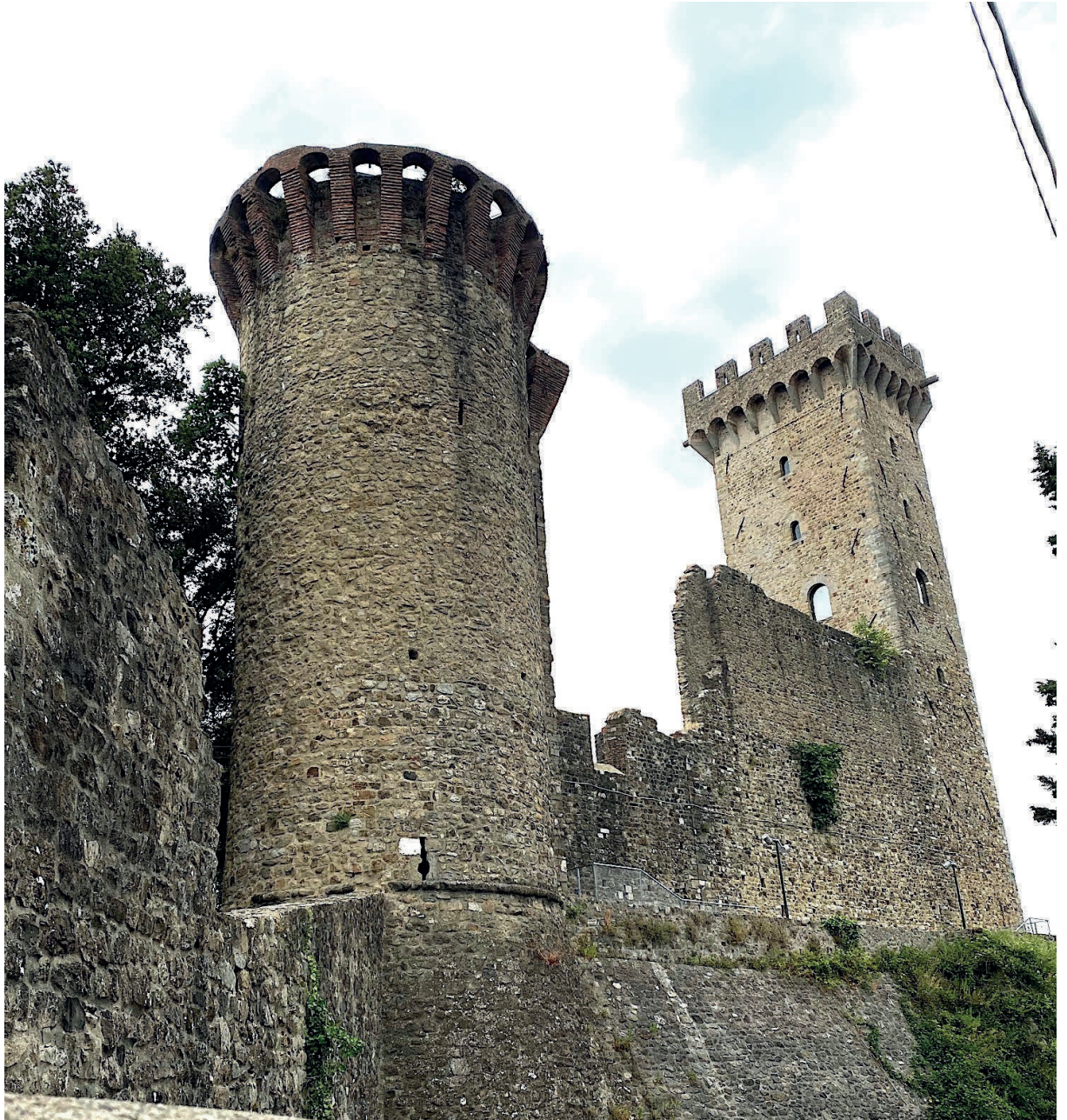
Figura 31 - Castelnuovo Magra: Torri del Castello dei Vescovi (Foto A.M.)
