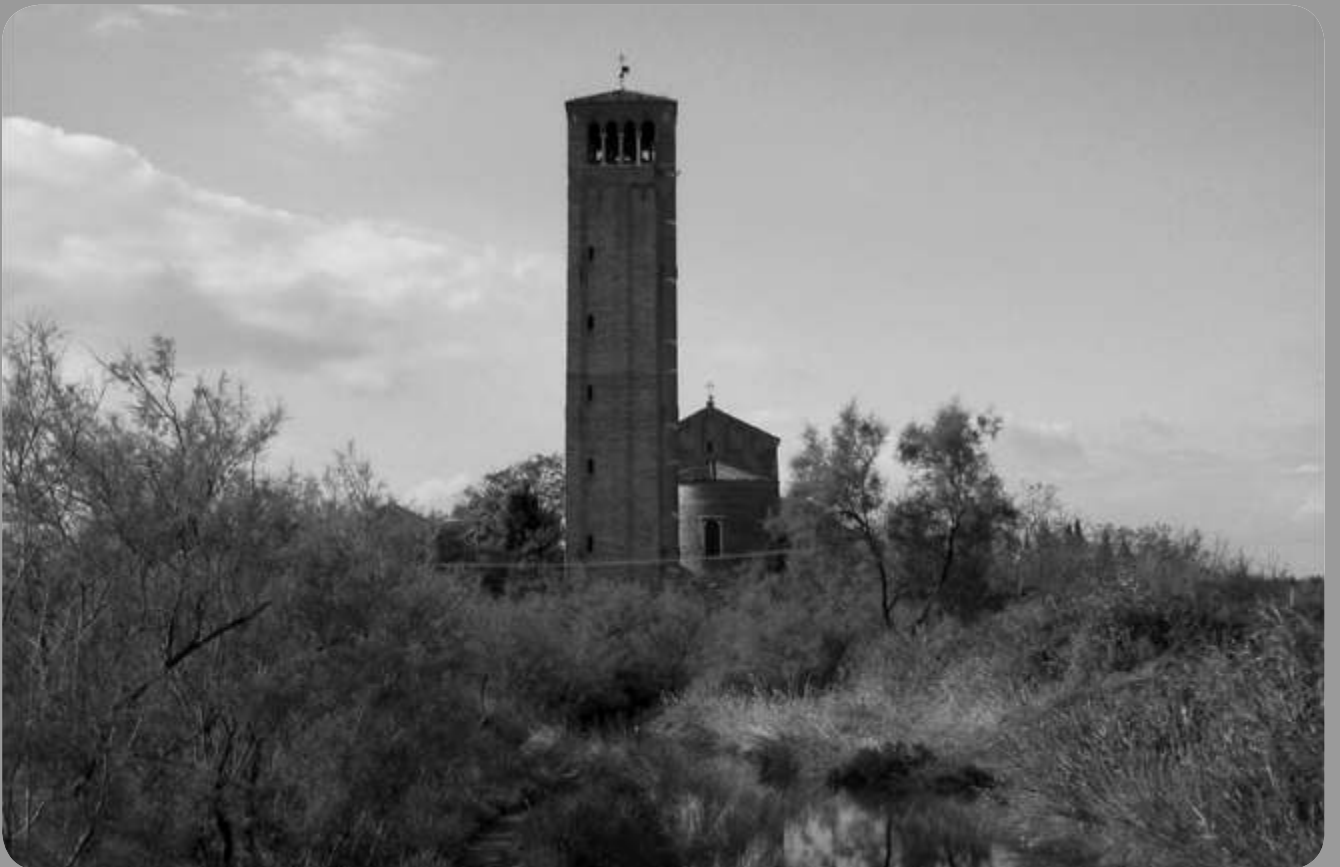
Fig. 3 - Santa Maria Assunta, vista dalla zona sud-orientale (D. Calaon)
