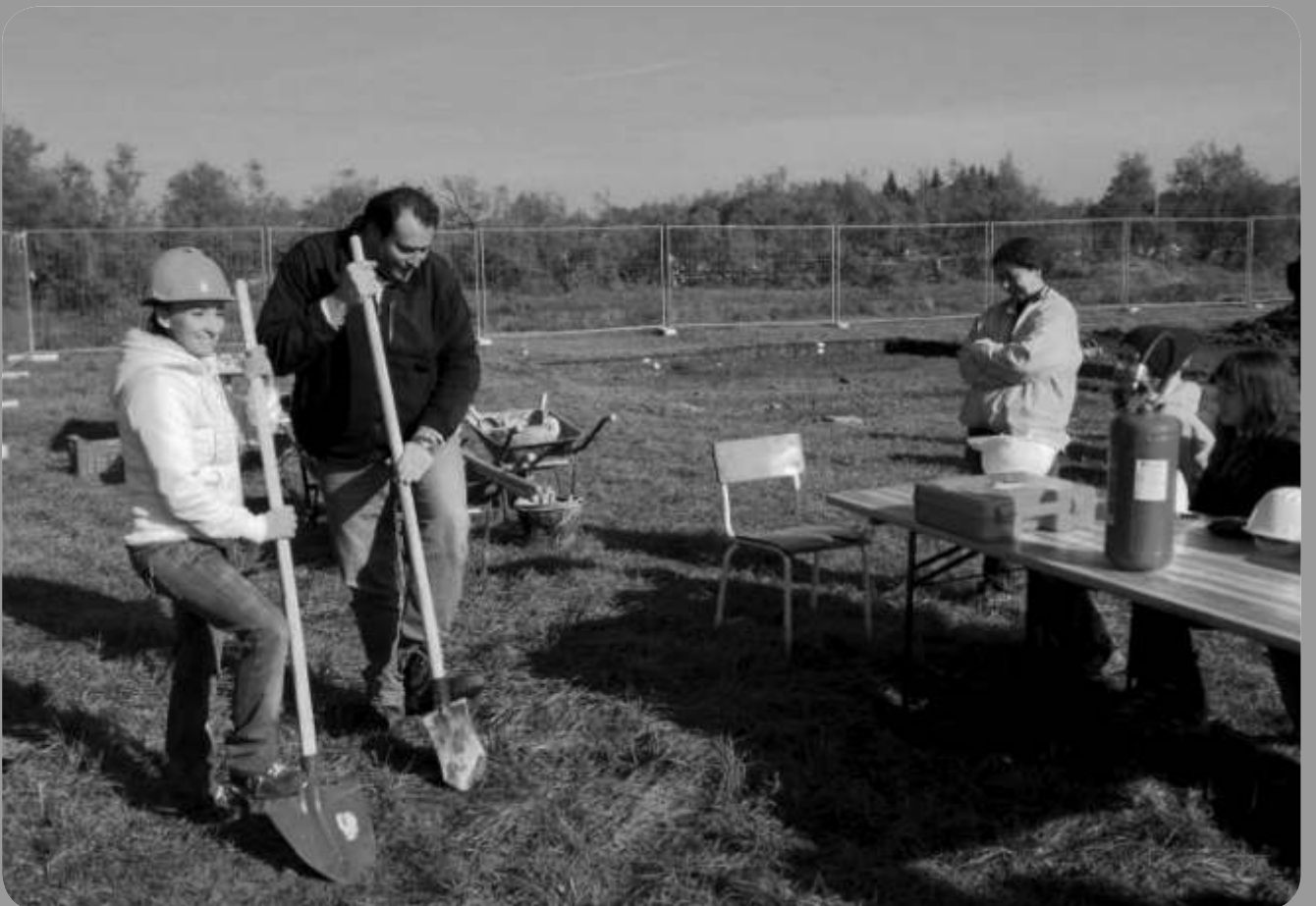
Fig. 2 - Lezioni sulla sicurezza in cantiere effettuate in situ (D. Scatto)
