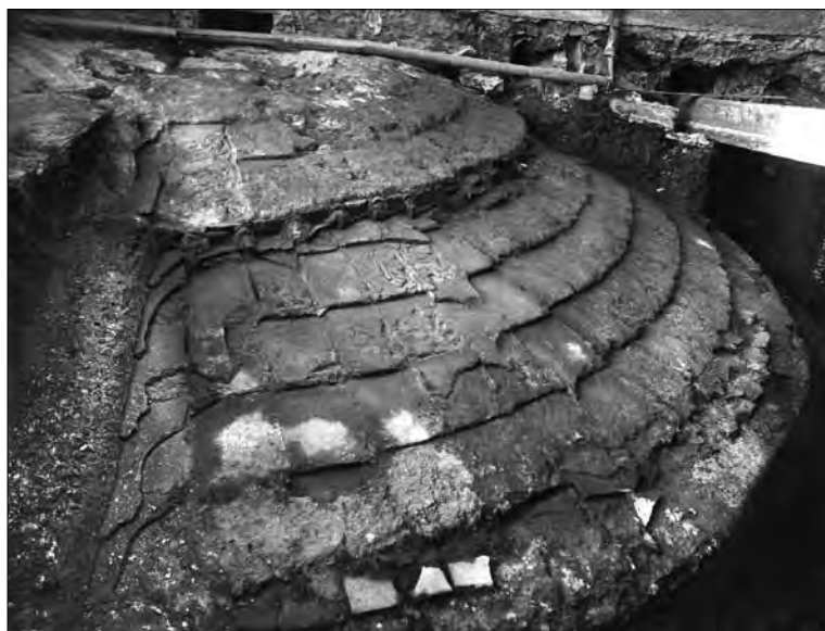
Fig. 5. Il sistema di copertura dell'estradosso della volta dell'aula del Piccolo Emiciclo.
