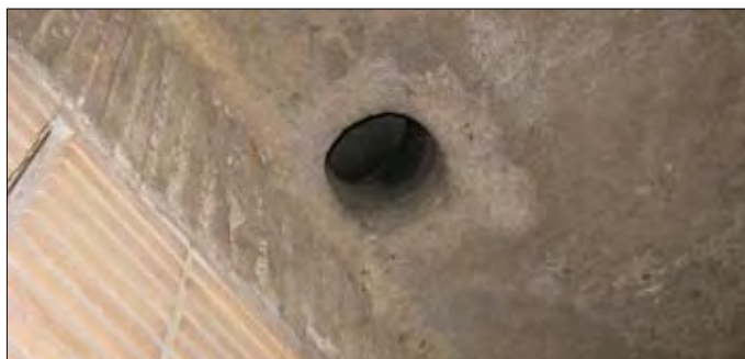
Fig. 2. Tubulo fittile inserito nella volta dei Mercati di Traiano per il deflusso delle acque piovane.
