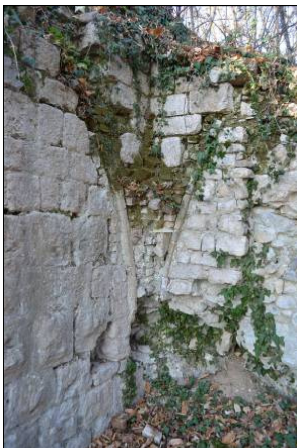
Fig. 14 - Ambiente quadrangolare, resti di una delle imposte angolari della volta in laterizi, da SE (foto D. Cesana).
