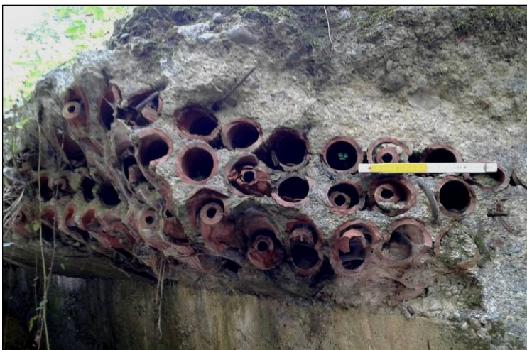
Fig. 4 - Particolare dell'imposta dell'impalcato della spalla NE, da S (foto S. Pruneri).
