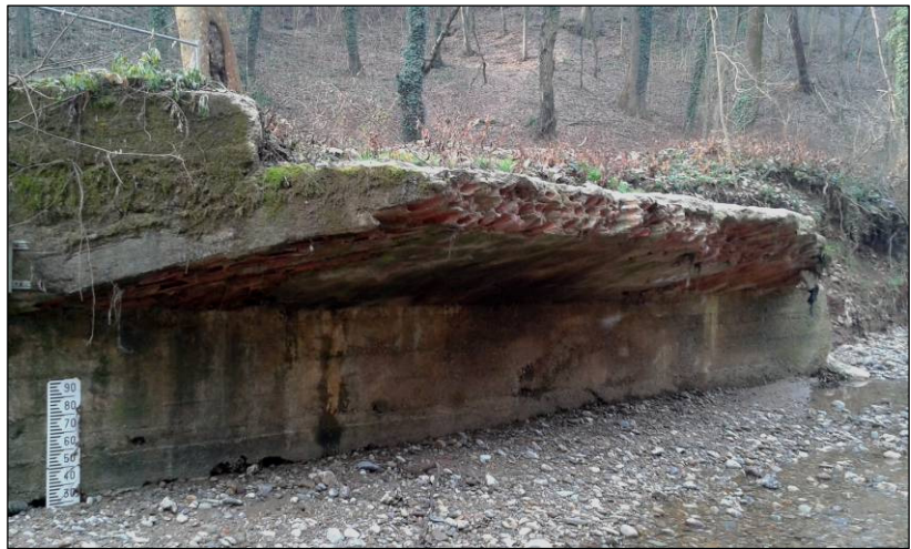
Fig. 3 - L'imposta dell'impalcato della spalla SO, da E (foto S. Pruneri).
