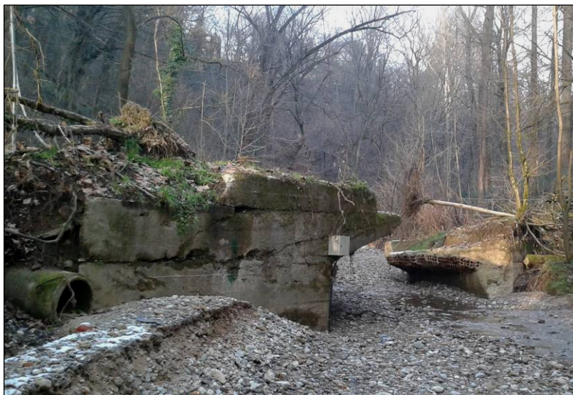
Fig. 2 - I resti del ponte, da S; in primo piano a sinistra è visibile la spalla SO (foto S. Pruneri).
