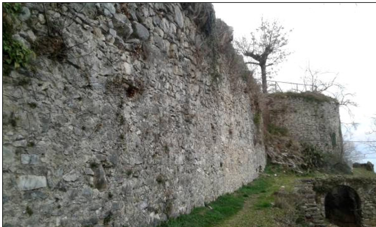
Fig. 17 - Settore Mediano. Il muraglione che si sviluppa tra i due baluardi a S della chiesa di Sant'Eufemia; sullo sfondo è visibile il baluardo E, a pianta semicircolare; le strutture ad arco poste immediatamente a valle delle strutture difensive sono state realizzate in epoca successiva. Da SO (foto L. Colombo).
