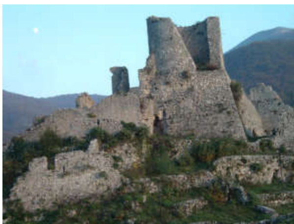
Fig. 6- Area antistante la torre mastia. In basso a sinistra è visibile una feritoia, accanto al varco di una finestra
