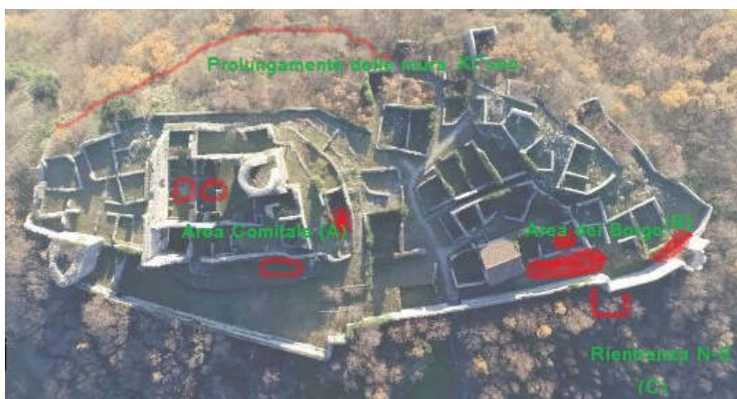
Fig. 1 - Vista dall'alto del borgo fortificato, con l'indicazione del prolungamento delle mura
