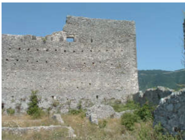
Fig.5-Parete posteriore del palazzo apicale. In alto ai lati della finestra, in tufo scuro le feritoie da arco._
