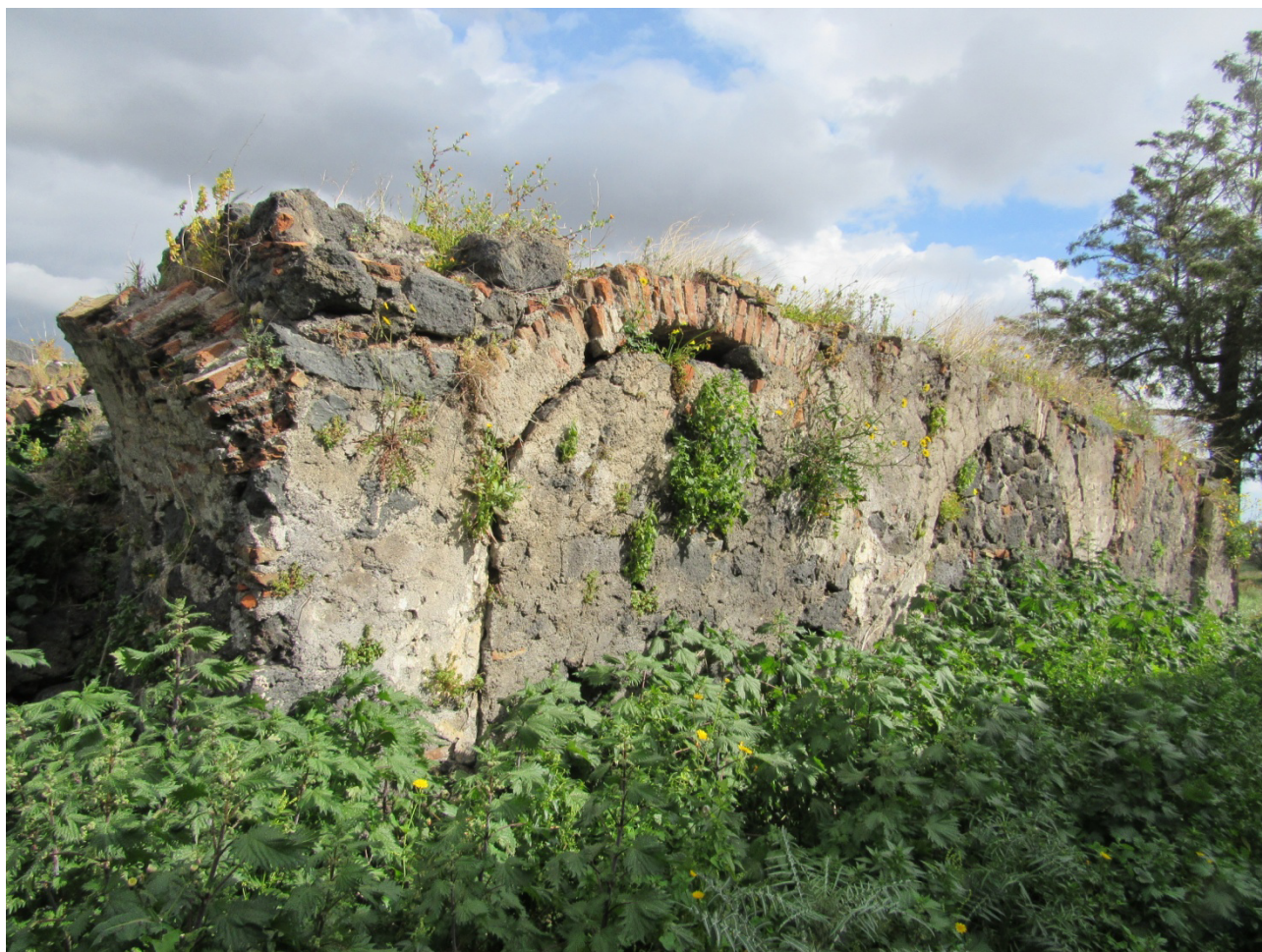
Prospetto lato sud con presenza di arcate esterne, con successivi tamponamenti - foto Mario Guarnera
