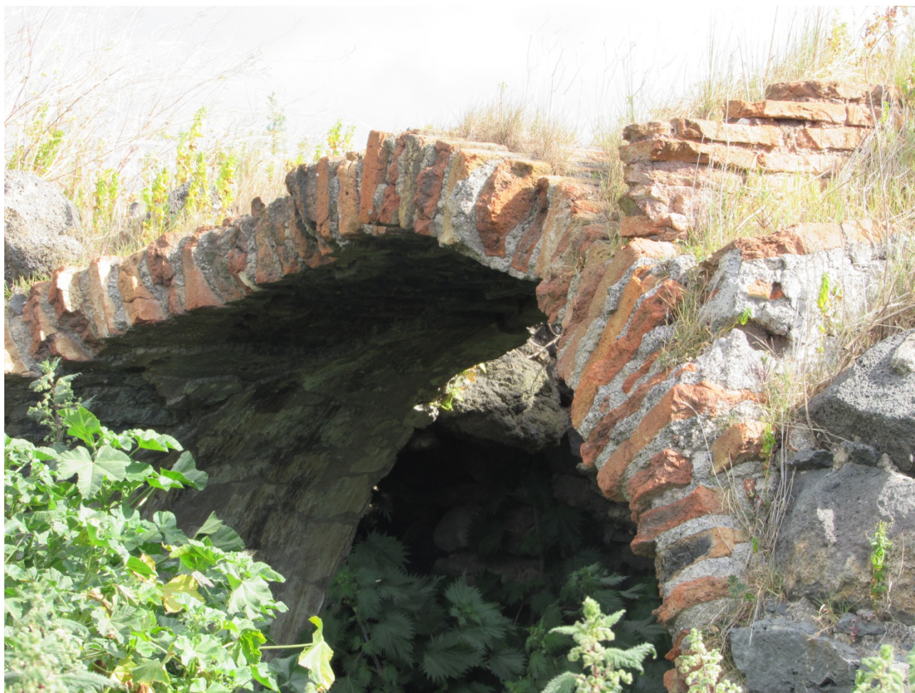
Particolare di una "volta a botte" sul lato ovest con, in evidenza, alcune tipologie di laterizi - foto Mario Guarnera
