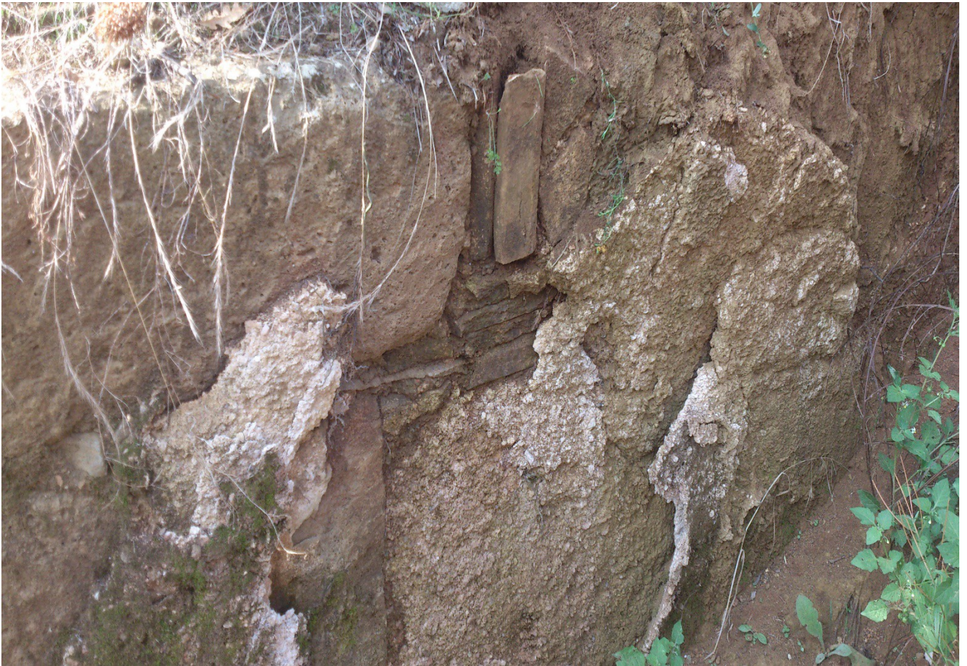
Parete laterale sud, oramai quasi senza intonaco mostra il fondo in terra coperto al meglio con parti di tegole
