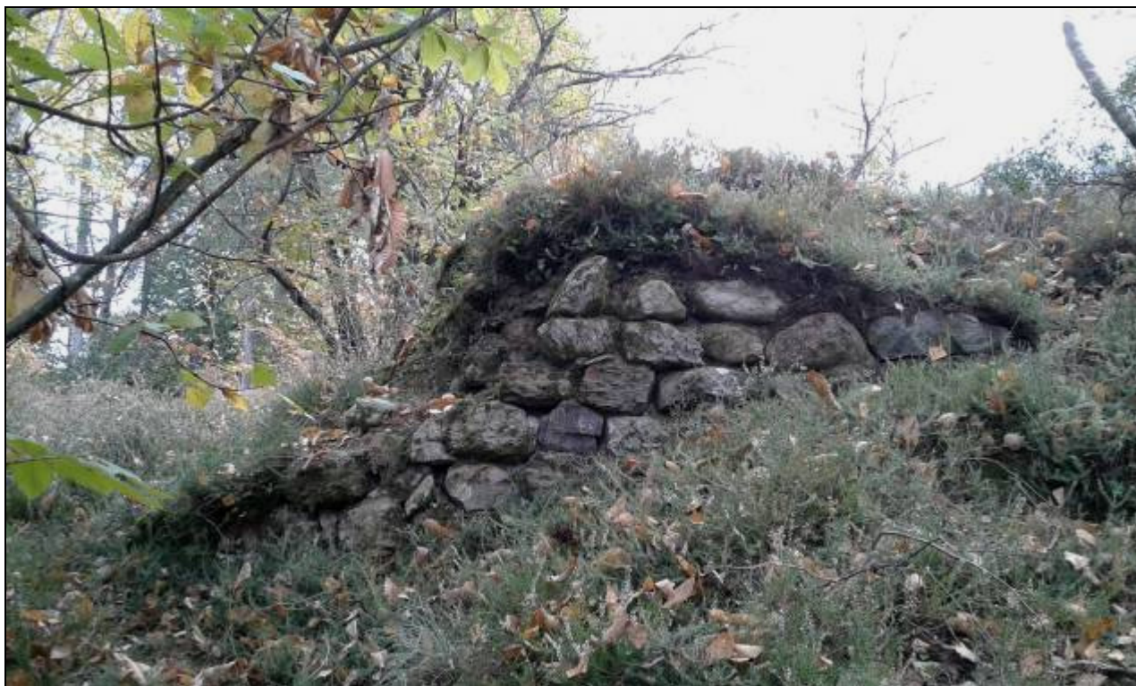
Fig. 18 - La struttura muraria US 4, da O (foto S. Pruneri).
