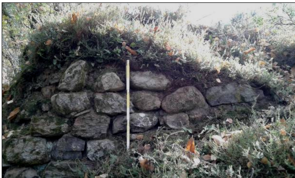
Fig. 19 - Particolare del paramento di US 4, da O (foto S. Pruneri).
