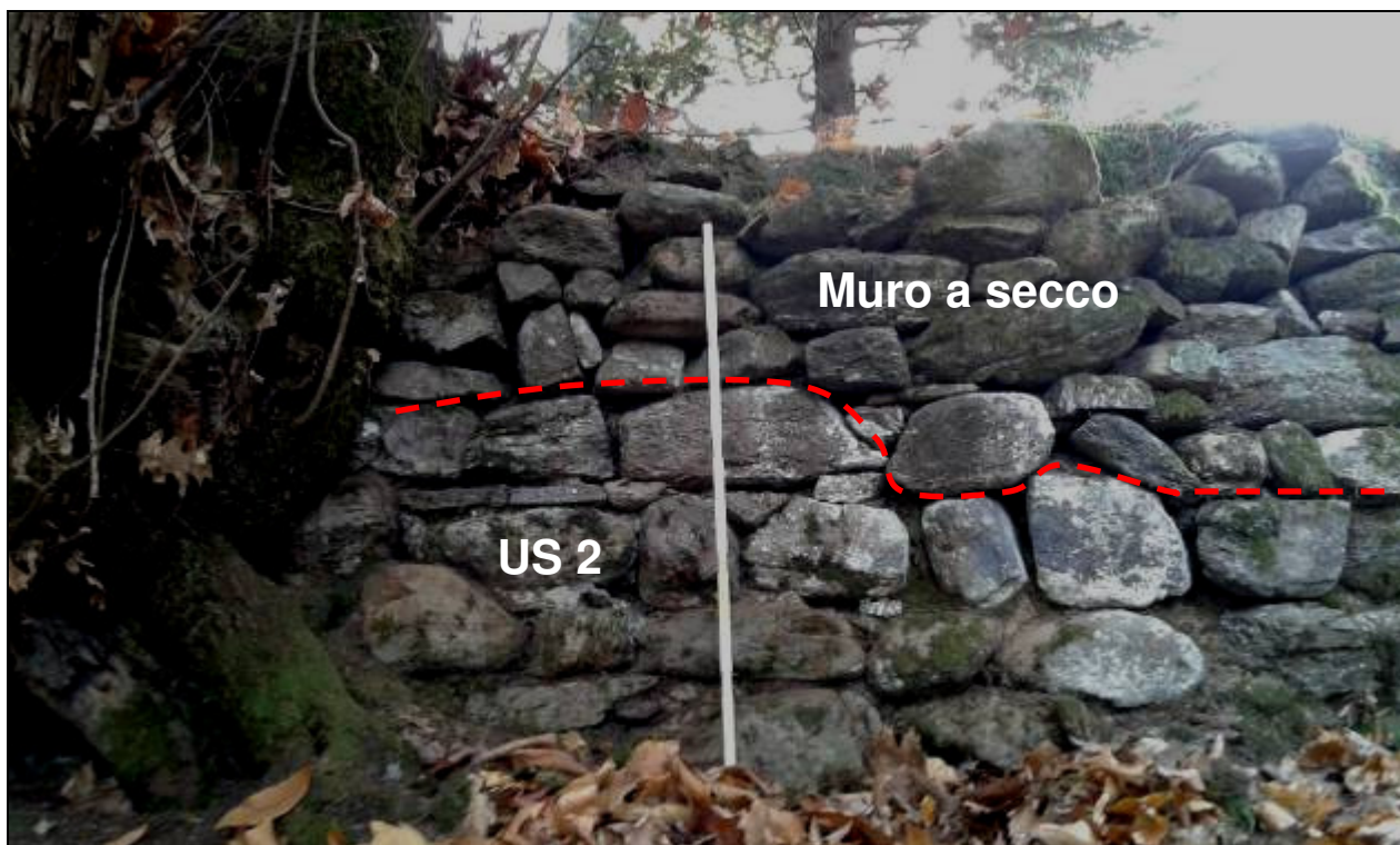
Fig. 14 - Il paramento della struttura muraria US 2, da N (foto S. Pruneri).
