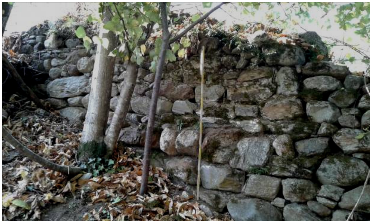
Fig. 8 - La struttura muraria US 1, da ENE (foto S. Pruneri).
