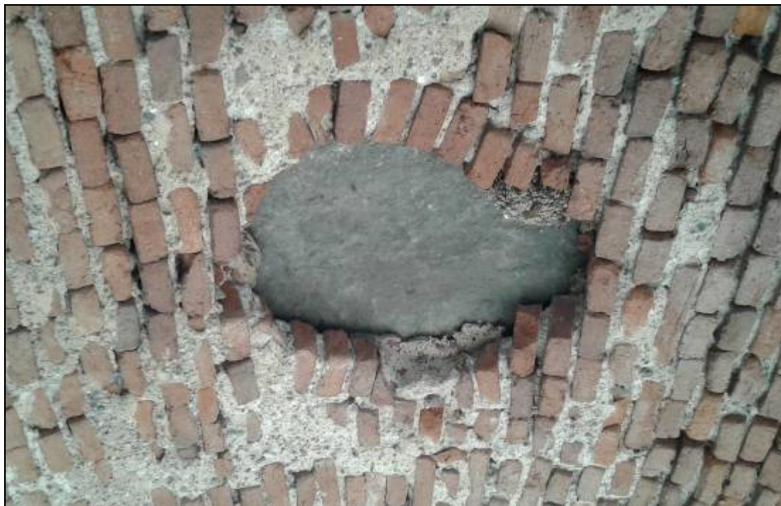
Fig. 35 - Apertura sub-circolare, chiusa da una lastra di pietra, visibile al centro della volta posta alla base della torre (foto M. Malvaso).
