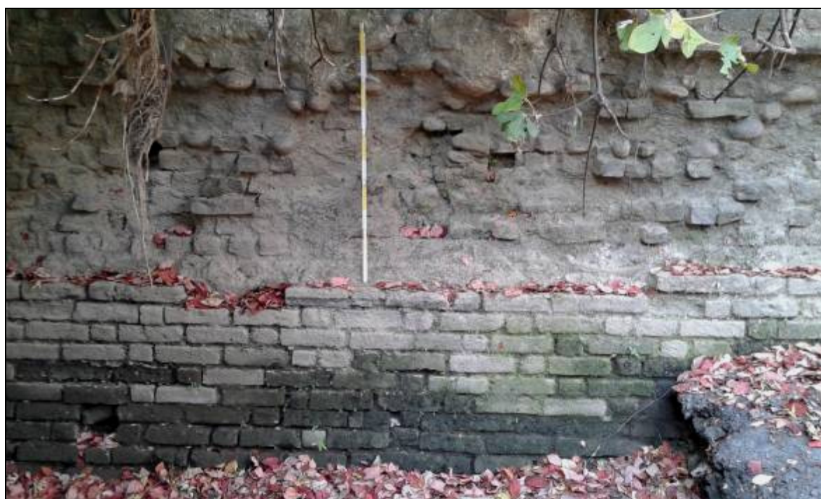
Fig. 42 - Alveo del fiume Lambro. Altra porzione del tratto orientale delle mura del castello, da E. Sopra il paramento in laterizi della scarpa emerge il sottostante riempimento a sacco del muro, in ciottoli e laterizi di reimpiego legati da malta abbondante. Da E (foto S. Pruneri).
