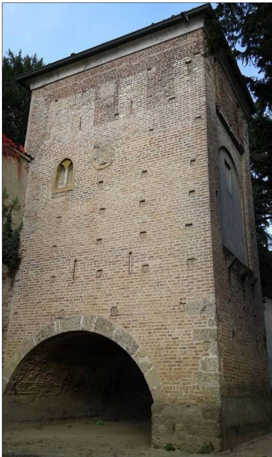
Fig. 28 - L'unica torre superstite del castello di Monza, ubicata lungo il corso del Lambro poco a monte del ponte di via Azzone Visconti, da SE; dotata di ponte levatoio, essa collegava il castello alle mura del borgo oltre il fiume. Sono ben visibili i merli a coda di rondine riferibili alla prima fase della struttura, lo stemma in pietra di Carlo II di Spagna (a destra della finestrella murata) e, più in basso, due feritoie tamponate; sotto l'arcata alla base della torre scorre ancora l'acqua del fiume (foto S. Pruneri).
