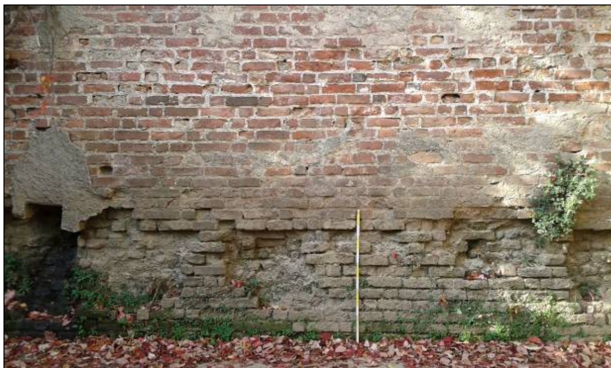
Fig. 38 - Alveo del fiume Lambro. Particolare del paramento della cortina difensiva orientale del castello, da E. In questo punto la base a scarpa delle mura non è visibile, essendo coperta dal fondo in cemento dell'alveo artificiale (foto S. Pruneri).
