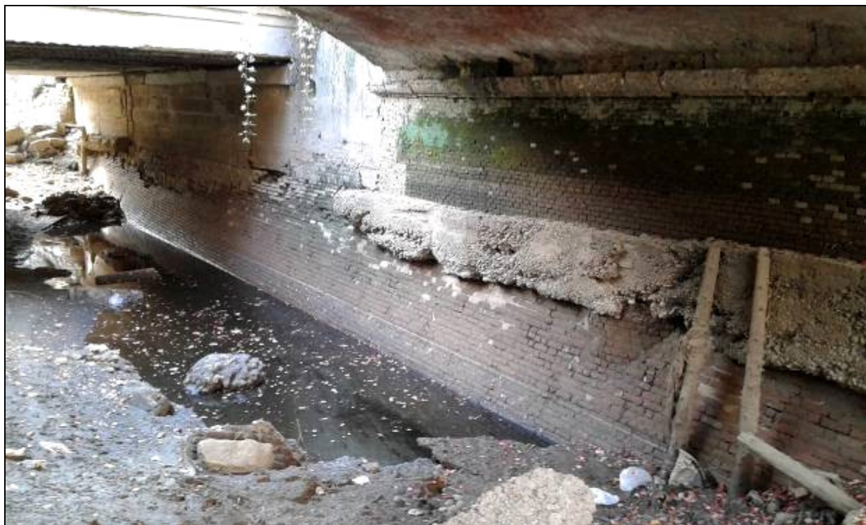
Fig. 39 - Alveo del fiume Lambro. Al di sotto del ponte di via Azzone Visconti (in primo piano) e del ponte ferroviario ad esso parallelo, si conserva, all'interno di una porzione di alveo priva della copertura in cemento, un tratto della base a scarpa delle mura orientali del castello, lungo una quarantina di metri. Da NE (foto S. Pruneri).
