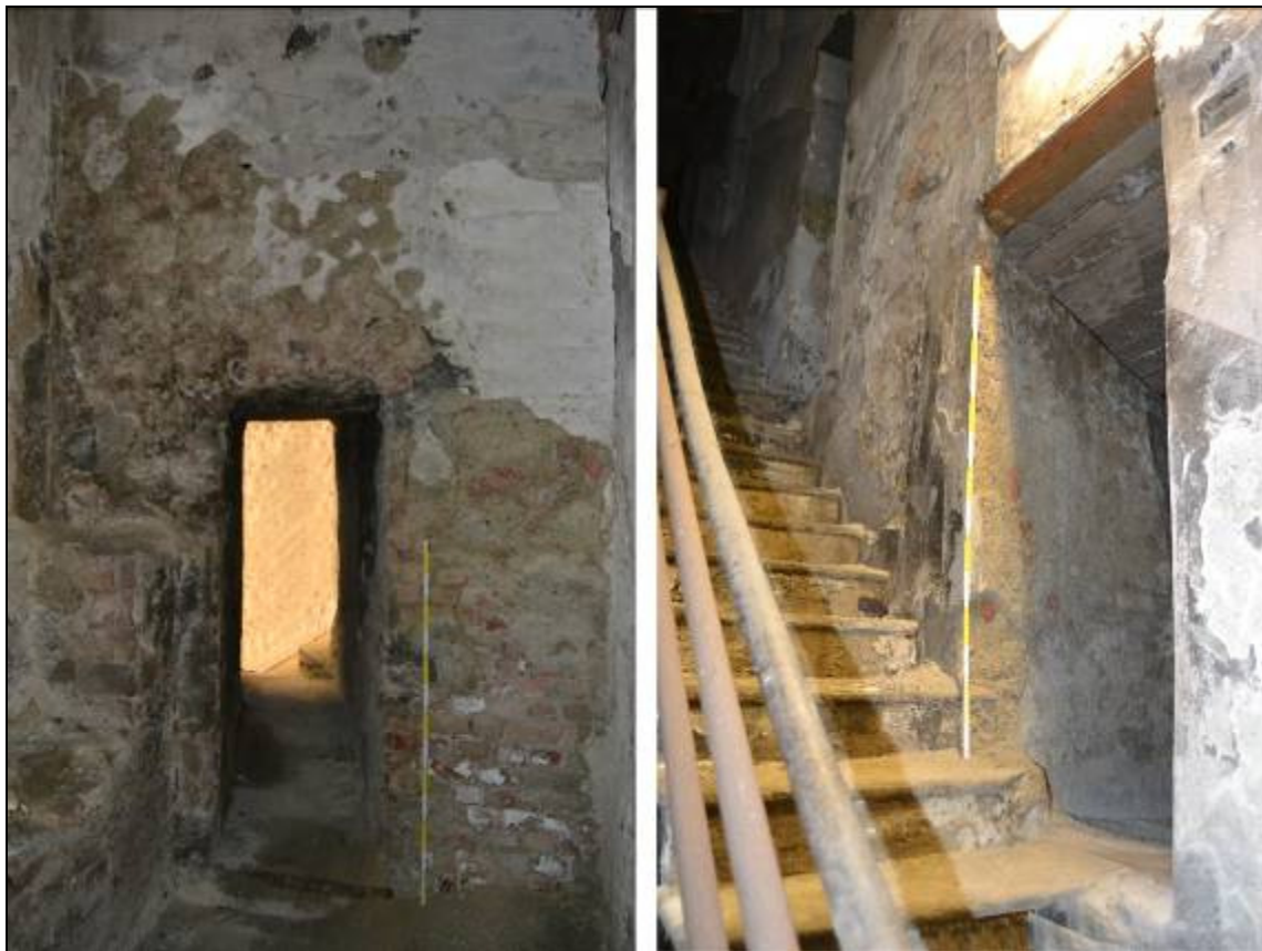
Fig. 45 - Sotterranei della Rinascente. Due inquadrature, rispettivamente riprese da S e da NO, dell'imponente struttura muraria (di 2,35 m di spessore) riferibile al prospetto S del palazzo del castello. Lo stretto cunicolo di passaggio è stato ricavato in rottura di muro in epoca successiva ( foto S. Pruneri ).
