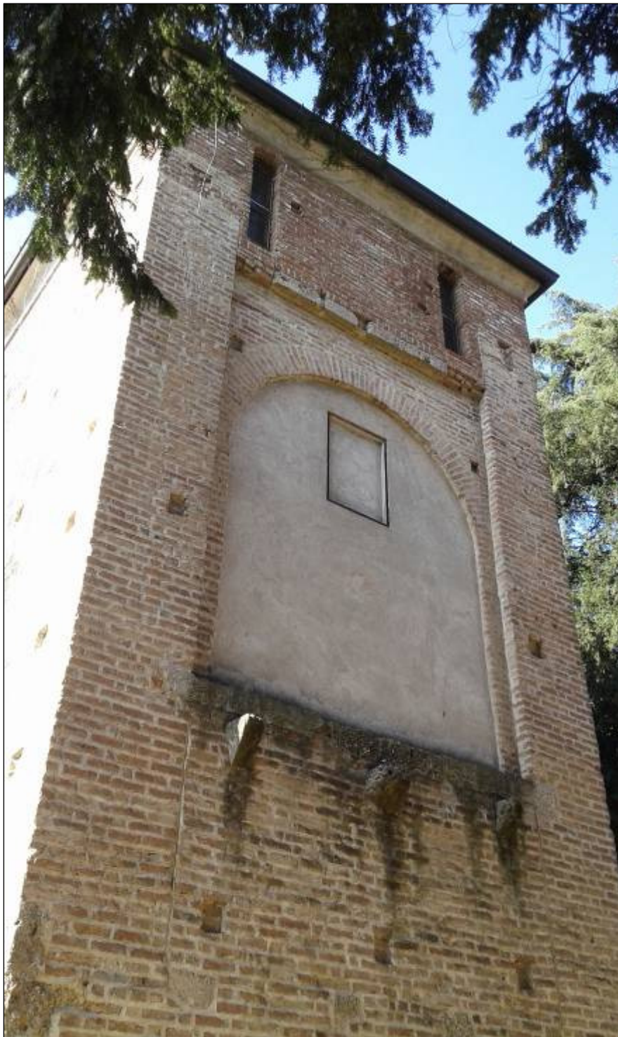
Fig. 30 - Particolare del prospetto orientale della torre, con le scanalature che alloggiavano i bolzoni del ponte levatoio, il portale carraio murato e i tre mensoloni su cui poggiava un'estremità del ponte stesso (foto M. Malvaso).
