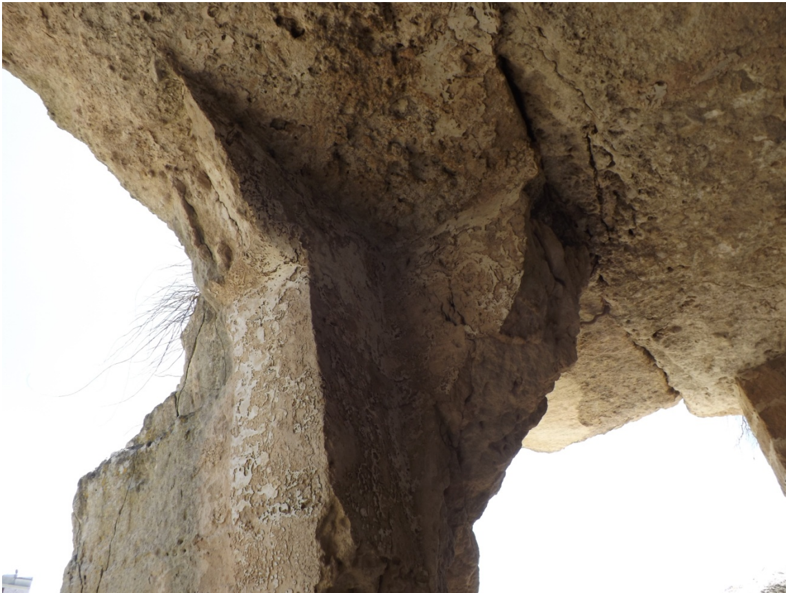
Figura 8: uno spigolo dei resti della grotta squadrata, con visibili tracce di intonaco
