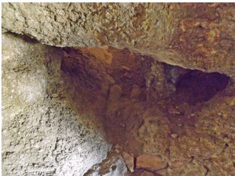
Figura 14: canalizzazione che collega l'interno della piccola grotta all'ampia struttura adiacente
