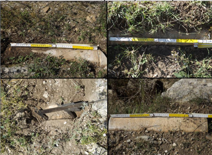
Fig. 7: tubi di misure diverse e collettore, presenti nel primo, terzo e quarto segmento dell'acquedotto
