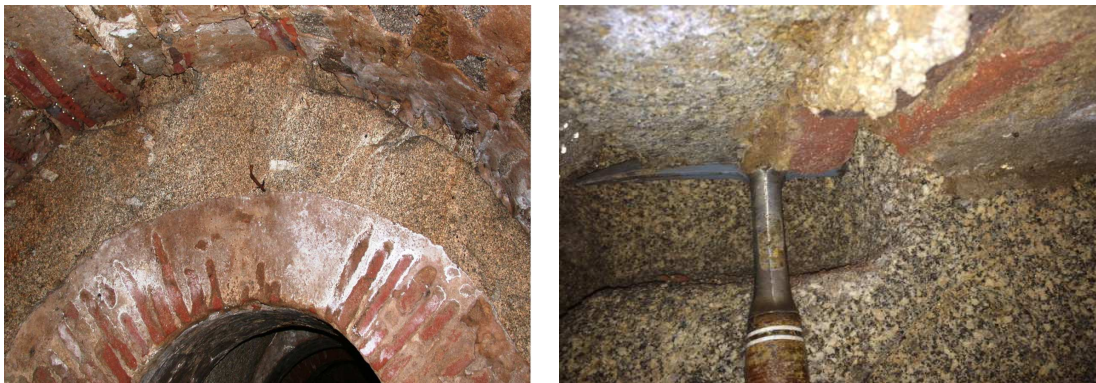
figg. 25/26 – Probabile sostegno rilevato nella camera sinistra
