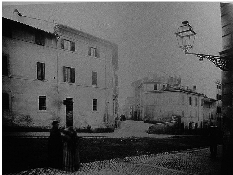
Fig. 2 - Roma, via Cavour all'angolo con via di S. Maria Maggiore in una foto degli inizi del '900.
