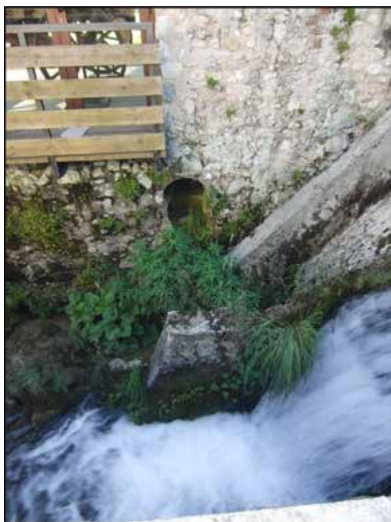
Fig. 68. Il vecchio foro per il passaggio dell'albero di trasmissione della ruota idraulica della segheria. Questo comandava una catena di trascinamento e il moto alternativo della sega da tavole.
