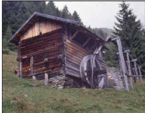
fig. 9. Mulino alimentato per di sopra con gora di alimentazione costruita con tronchi incavati di larice. Terento (BZ).
