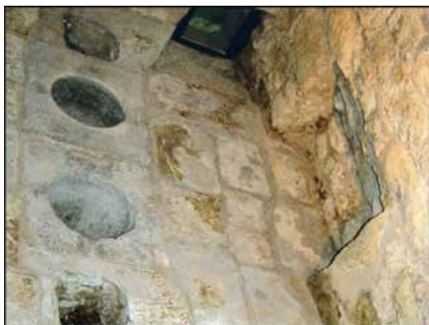
Fig. 65. Quel che rimane della macchina a pestelli. Le due pile in pietra, i fori dell'alloggiamento del telaio, il foro nel muro per il passaggio dell'albero a camme azionato dalla ruota idraulica alimentata per di sotto.
