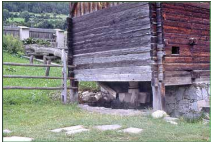
fig. 7. Museo etnografico di Teodone (BZ): Mulino con ruota orizzontale a pale inclinate in legno azionate da un canale di gora ricavato da tronchi d'abete.
