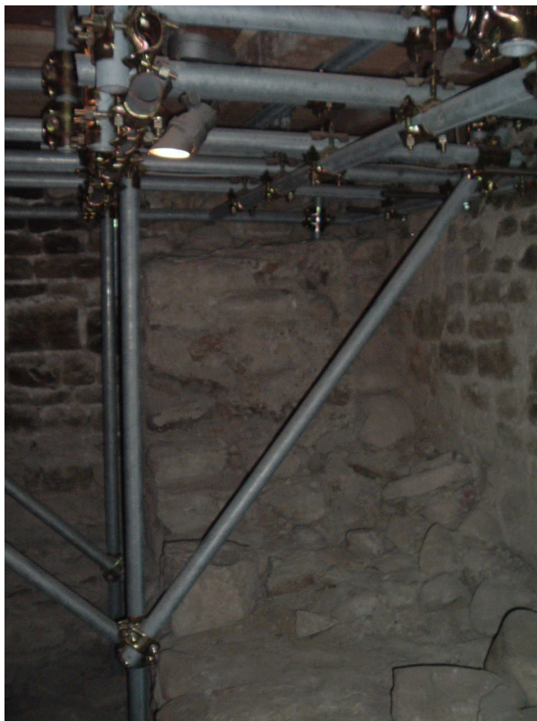
Fig.12-Resti della scala di accesso del lato Est.
