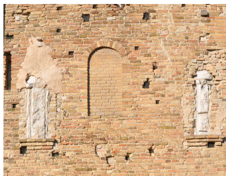
Fig. 8. Chiesa di Ognissanti. Esempio di muratura ed aperture con più fasi.
