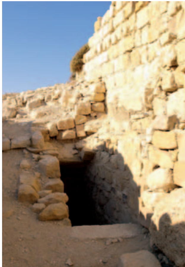
Fig. 3 - Ingresso superiore della galleria del Castello di Shawbak (foto Burri).
