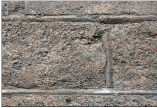
5. Stilatura dei giunti tra i blocchi della porzione di torre risalente alla fase romana. (S.E. Zanelli)
