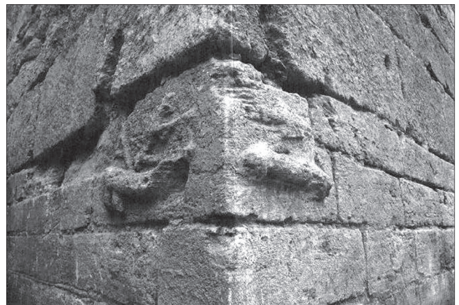
11. Rilievo laser-scanner dello spigolo sud-est della Torre dei Balivi. (L. Bornaz)
