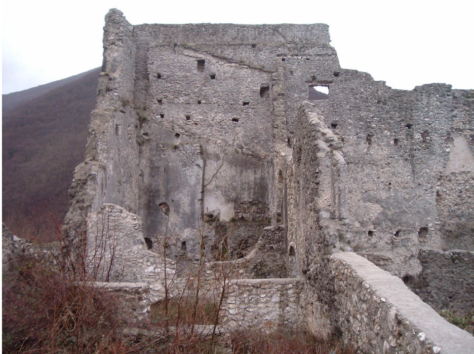
Vista d'insieme degli ambienti palaziali. Al centro dell'ambiente di destra si nota la traccia del camino. Nell'ambiente a sinistra è, e la rientranza in alto a lato sinistra, oltre alle modifiche strutturali dell'ambiente (tetto spiovente trasformato).
