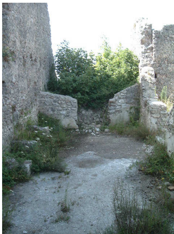
Palazzo apicale,interno frontalmente il divisorio della torre di destra, si noti in alto a destra la non coesione delle strutture riferibile all'ingresso ogivale gotico.
