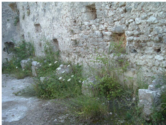
Interno parete sud dell'ambiente rettangolare del piano terra del palazzo comiziale, si notano i pilastrini , e le finestrelle passaluce. Sfalsati i fori quadrangolari di ammorsamento delle travature del piano superiore.
