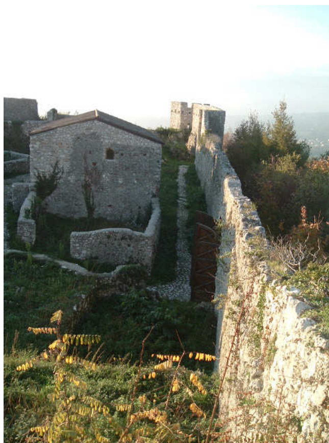
Vista della cinta da nord est, è visibile l'ingresso, il corridoio perimetrale ed in fondo la rientranza sfalsata e la semitorre circolare d'angolo.
