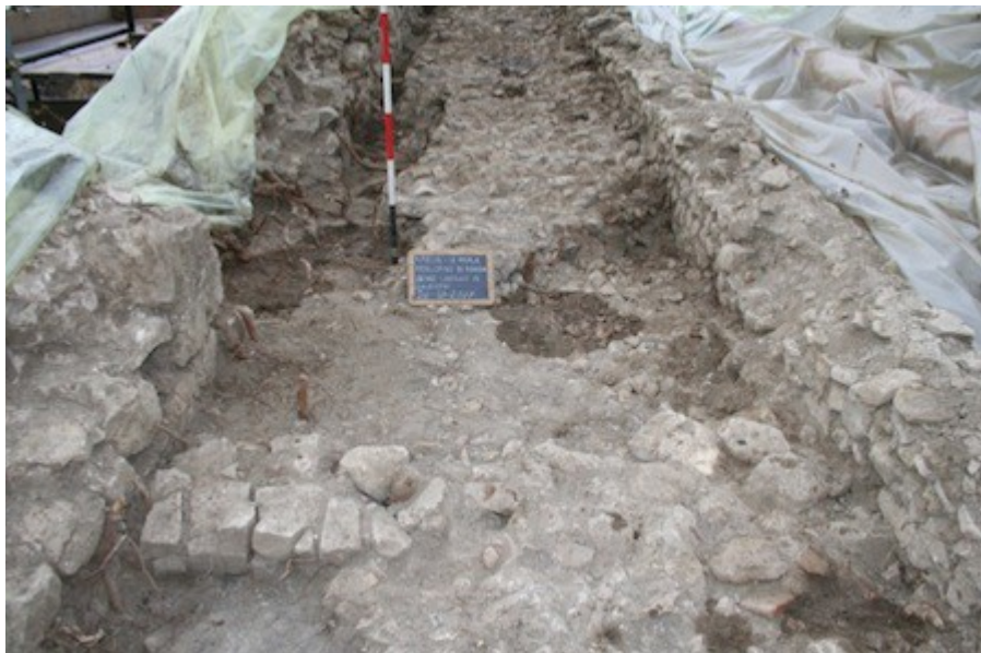
Crollo interno del percorso di ronda a valle del crollo, particolare.
