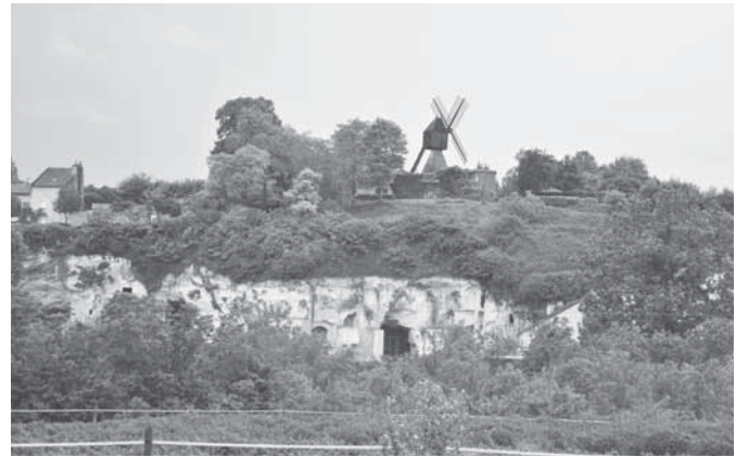
Fig. 7 Turquant hillside général vue from the valley.
